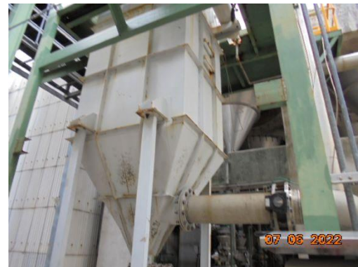
รูปที่ 4 Bag Filter ในระบบบำบัดเหม็ดในถ่อน
