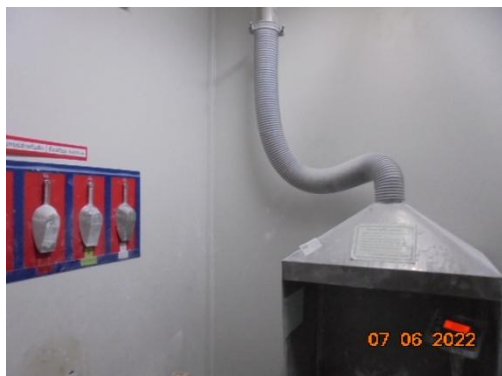
รูปที่ 33 พัดลมดูด AH Salt ออกนอกอาคารผลิต
