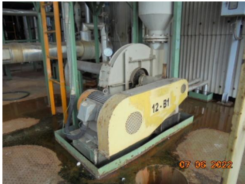
รูปที่ 35 Blower สำหรับดูดไอควันของแลกตัม
