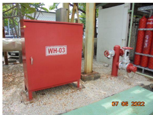
รูปที่ 25 Hose Box และหัวจ่ายน้ำดับเพลิง
