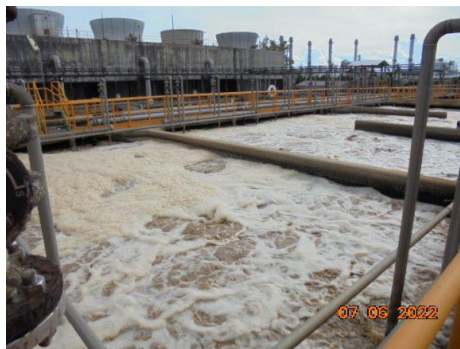
รูปที่ 9 ระบบบำบัดน้ำเสียของ โรงงานผลิตสารคาโปรแลคตัม
