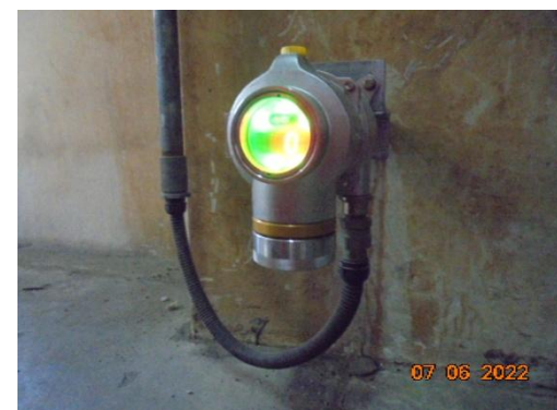
รูปที่ 28 Flammable Gas Detector
