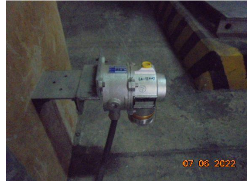
รูปที่ 24 Gas Detector
