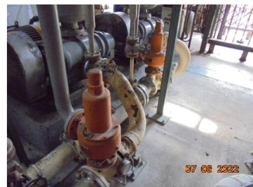
รูปที่ 39 Interlocking Valve และ Safety Relief Valve
