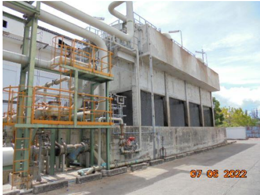
รูปที่ 7 Cooling Tower
